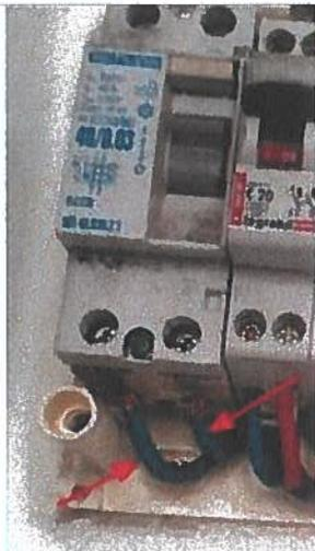
Description : A l'intérieur du tableau, la section d'au moins un conducteur alimentant les dispositifs de protection n'est pas adaptée au courant de réglage du disjoncteur de branchement.
