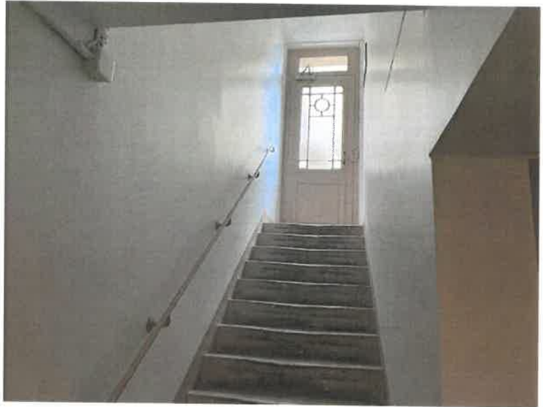
Escalier d'accès à la cave depuis l'extérieur
