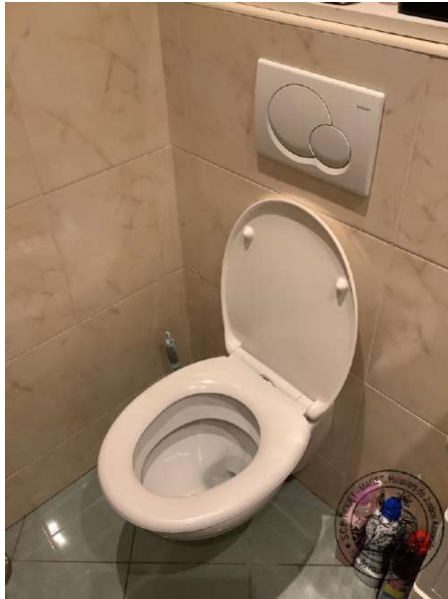
Toilettes suspendues en bon état
