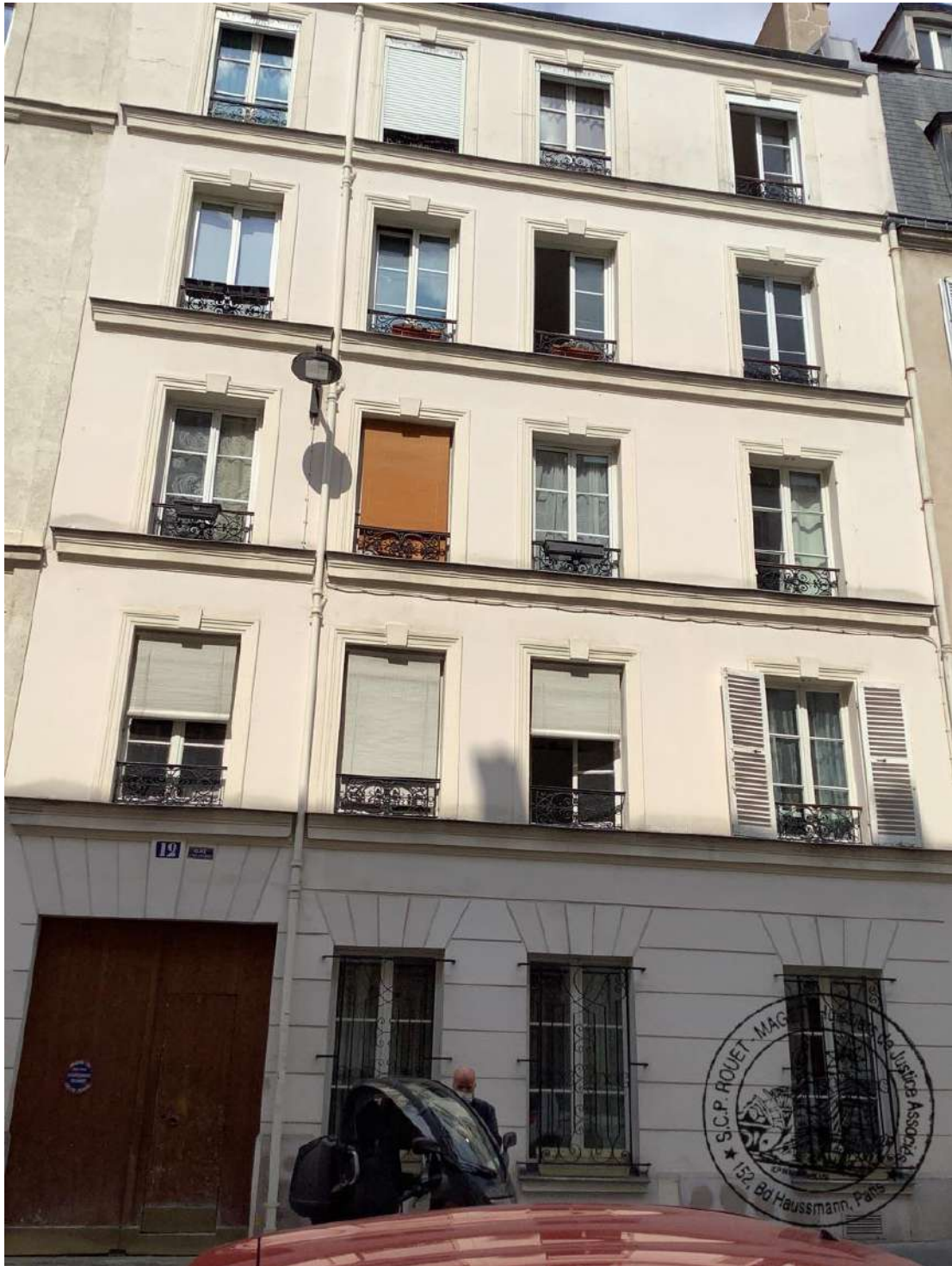
Façade de l'immeuble
