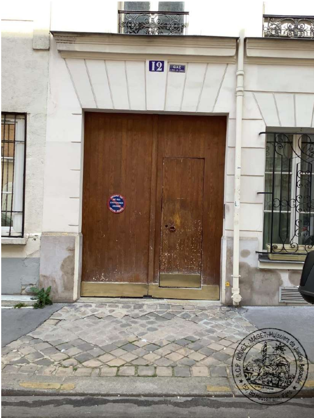
Porte d'entrée de l'immeuble
