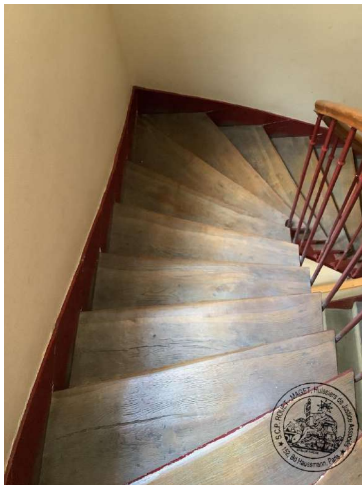
Les escaliers d'accès à l'appartement, en bois, sont en état d'usage
