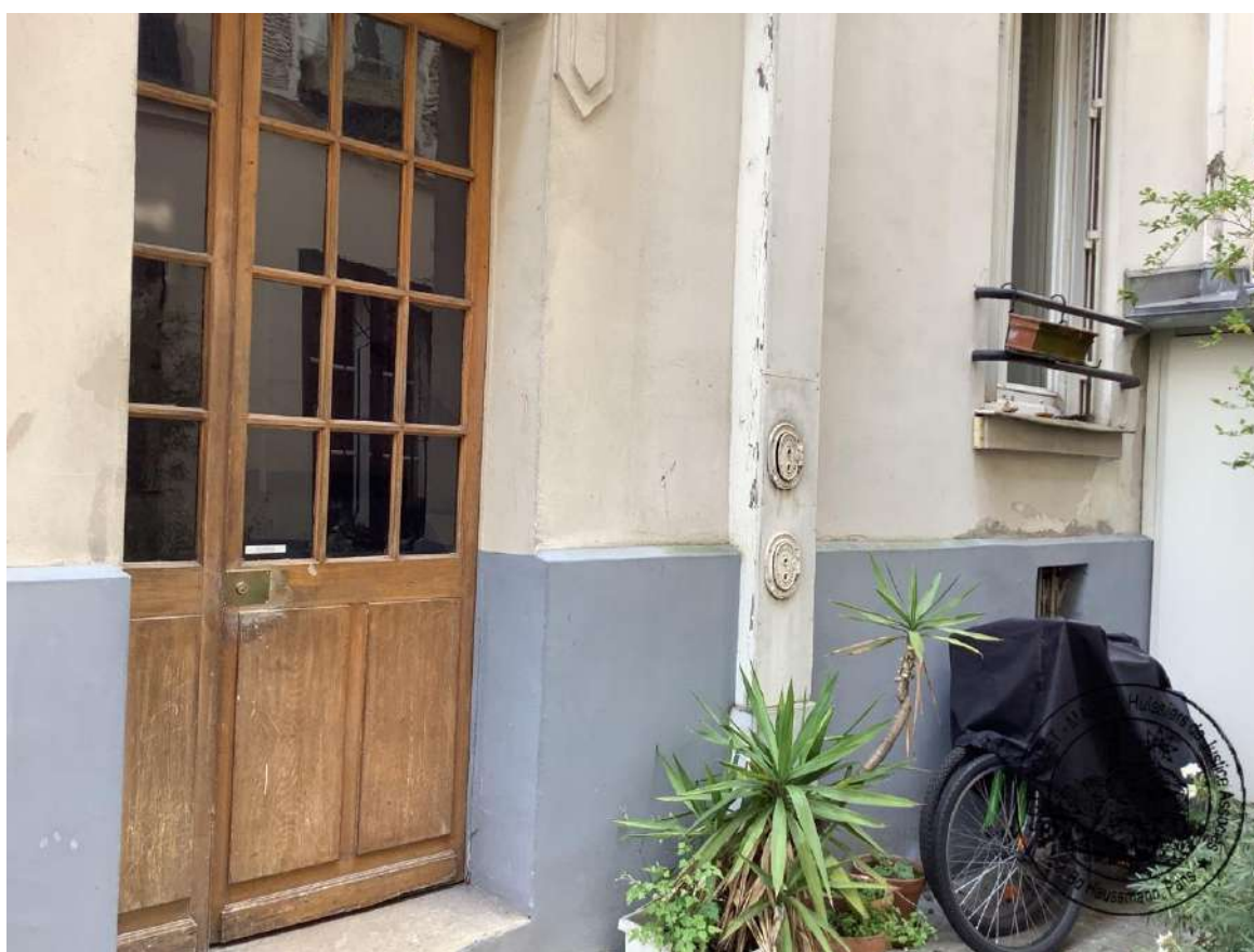
Porte d'entrée de l'immeuble donnant sur cour
