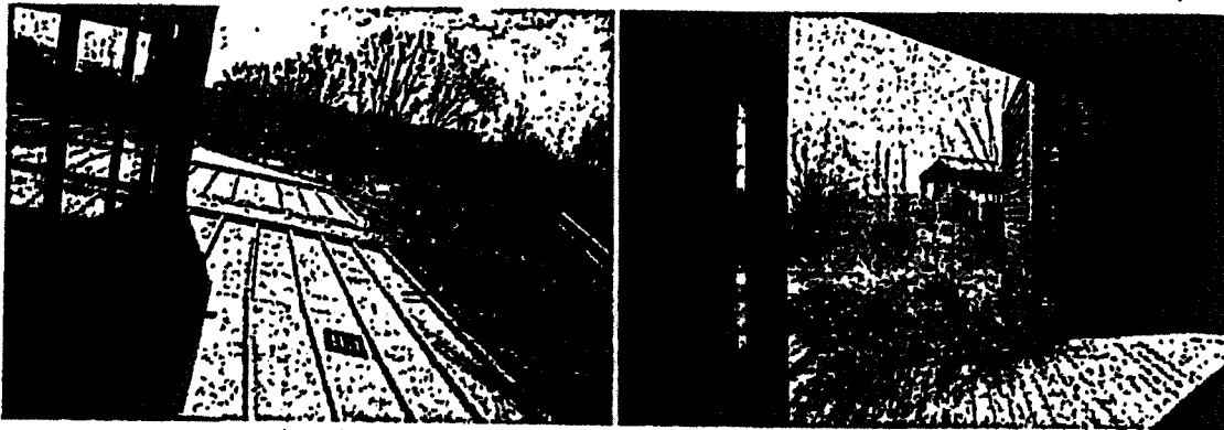
Extérieurs partiellement couverts avec dégradations par manque de planchers par endroits.
