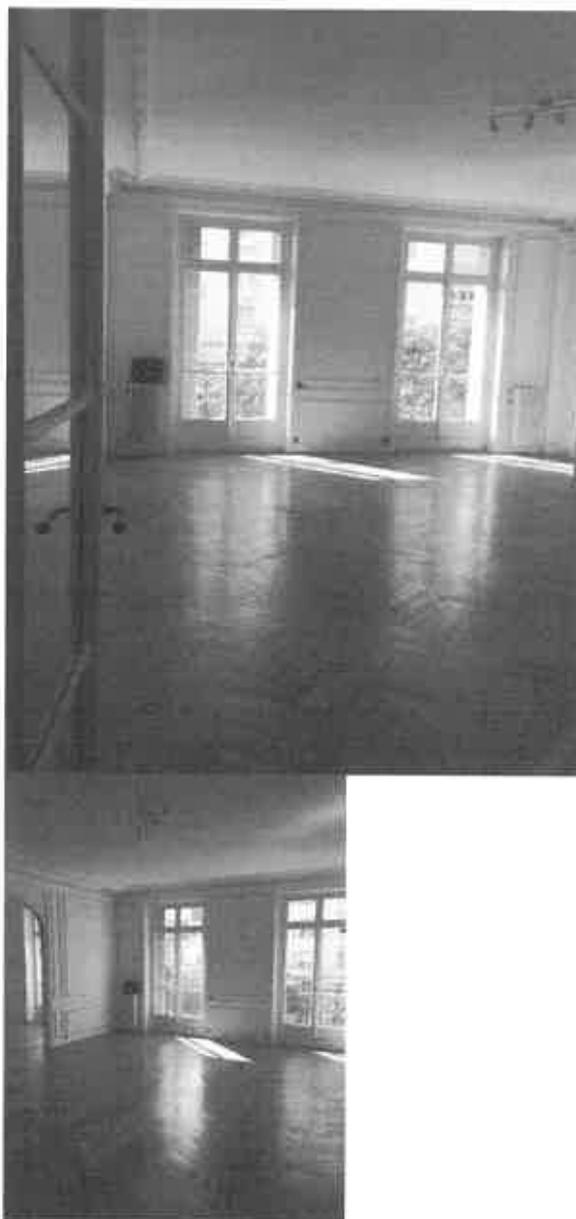
Le sol est recouvert d'un parquet en points de Hongrie abîmé et légèrement dégradé en partie centrale, laissant voir quelques manques entre les lattes. La vitrification est ancienne.
